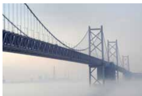
2 坂出市・瀬戸大橋
