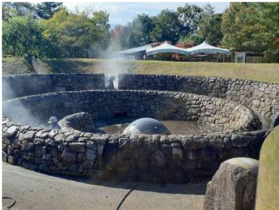
くすんだ石垣の高圧洗浄
