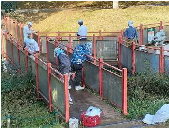
退色した鋼製の手摺の研磨
