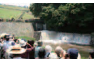
満濃池の樋門及び底樋管は、弥勒池の石穴建設で信望を得た軒原庄蔵が、安政の地震で決壊した満濃池堰堤下の石樋に代えて建設した底樋隧道とその出口であり、現在の底樋管の延長は 197m です。
