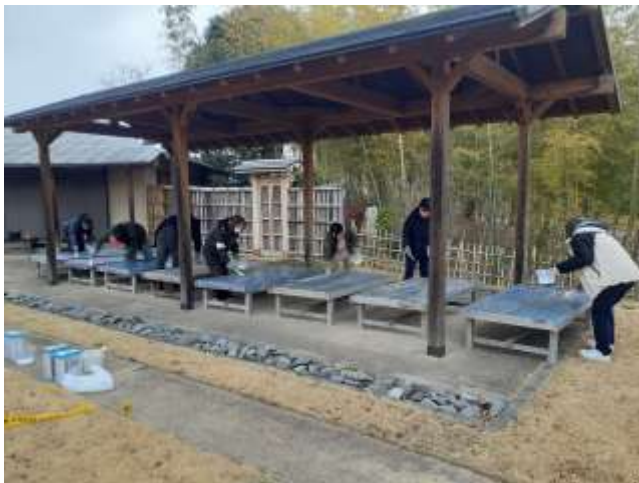
縁台の座面を中心に刷毛を使い保護材を塗装して頂きました。
